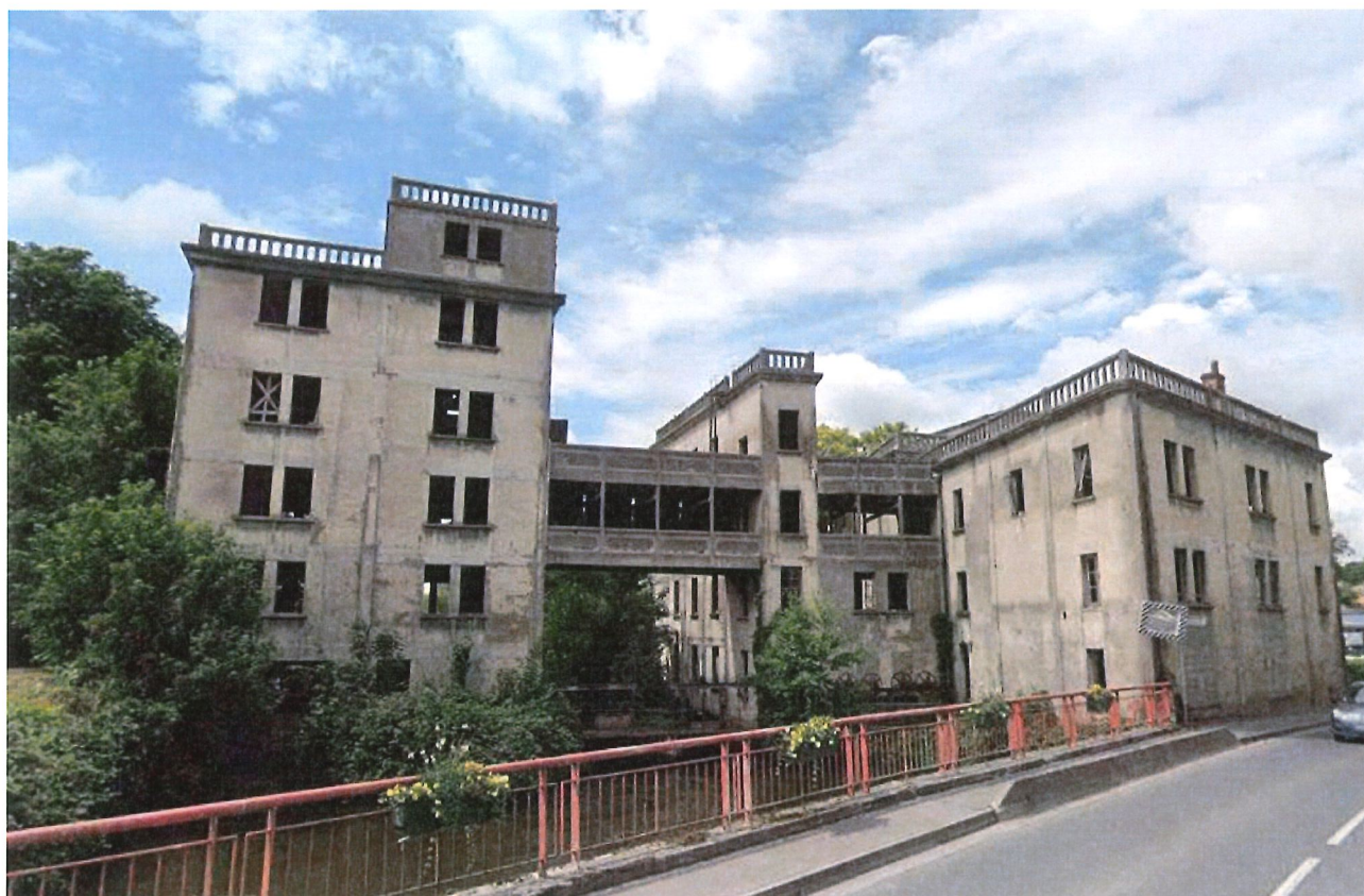
Vue depuis la route du moulin Damay à Péronne
