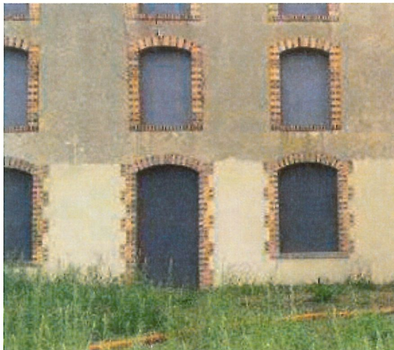
Exemple de bâtiment dont une partie des ouvertures ont été obturées pour les chauves-souris ©Laurent ARTHUR
